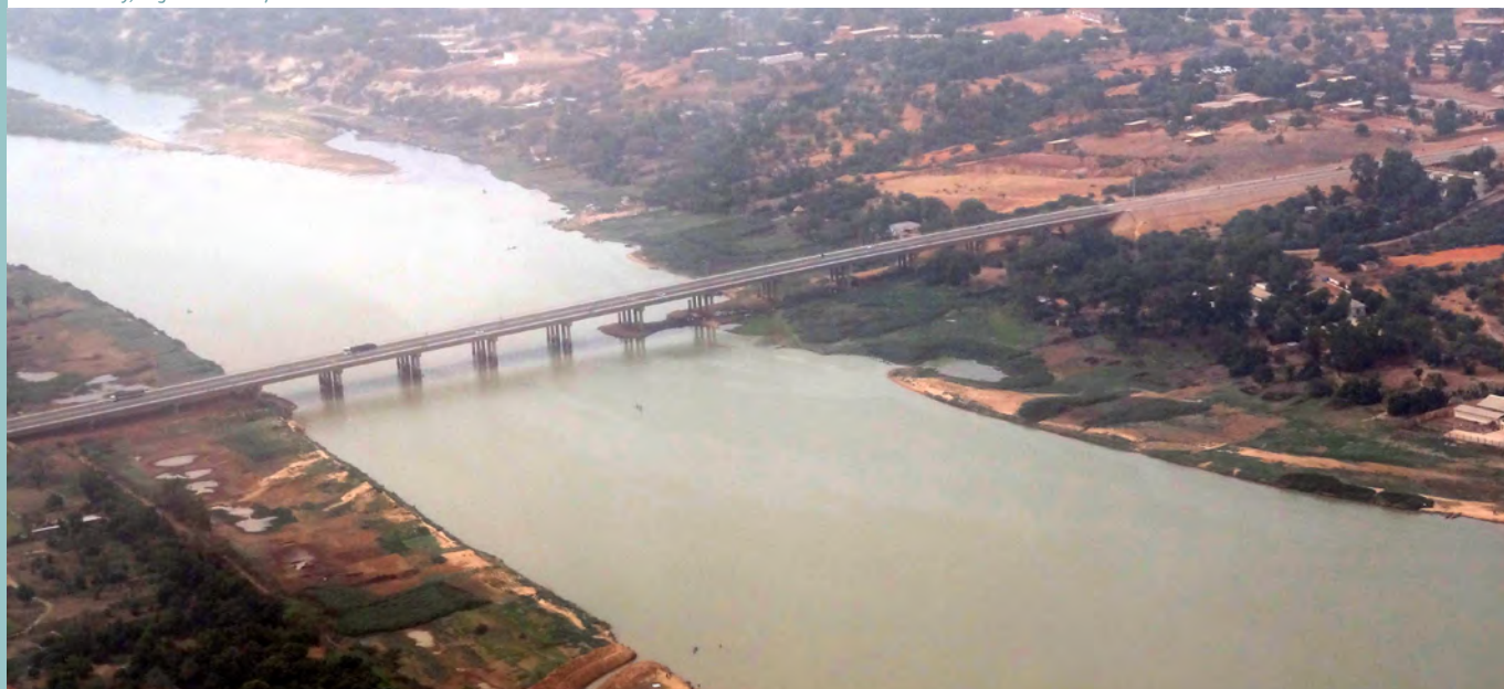
Vue aérienne du pont de l'amitié Chine-Niger, plus souvent appelé le « pont des chinois », inauguré le vendredi 18 mars 2011 et situé à Niamey, Niger. PHOTO : Jean Rebiffé.
